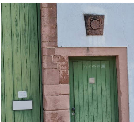
Einzigste was noch darauf die dritte Mühle
